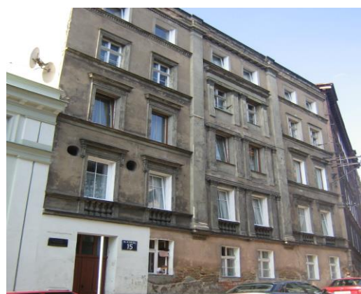
Budynek Wspólnoty Mieszkaniowej przy ul. Buczka 15 w Wałbrzychu (przed remontem elewacji).
