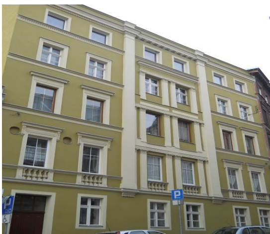
Budynek Wspólnoty Mieszkaniowej przy ul. Buczka 15 w Wałbrzychu (po remoncie elewacji).
