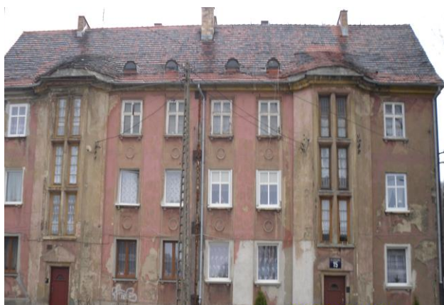
Budynek Wspólnoty Mieszkaniowej przy al. Wyzwolenia 59 w Wałbrzychu (przed remontem elewacji).
