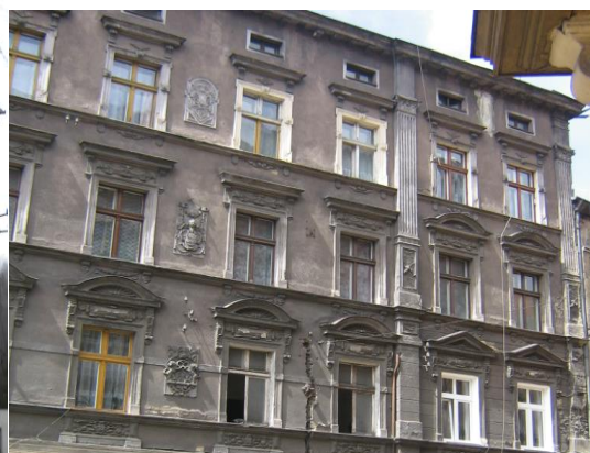
Budynek Wspólnoty przy ul. Lubelskiej 15,15a (przed remontem elewacji i dachu).
