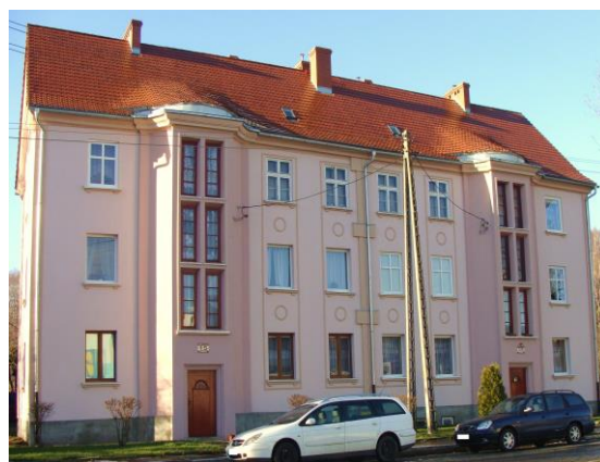
Budynek Wspólnoty Mieszkaniowej przy ul. Lubelskiej 15,15a w Wałbrzychu (po remoncie elewacji i dachu).
