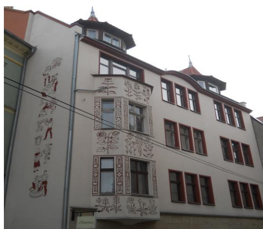
Budynek Wspólnoty Mieszkaniowej przy ul. Sienkiewicza 6 w Wałbrzychu (po remoncie elewacji i dachu).
